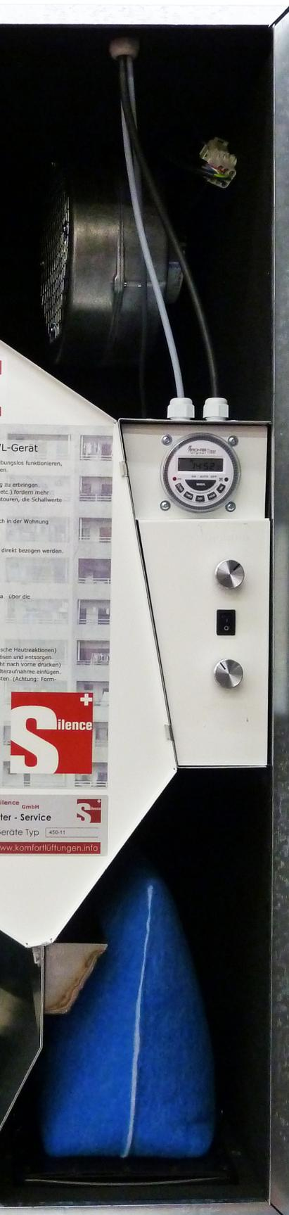
Der Fortluftventilator ist ebenfalls konstant-Volumen-geregelt und fördert das gleiche Luftvolumen wie der Zuluftventilator aus der Wohnung ins Freie.
